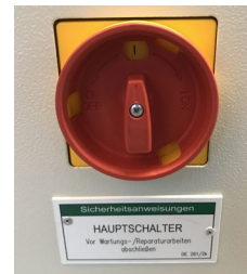
Rys. 16: przykład: wyłącznik główny do włączania i wyłączania regału i .
